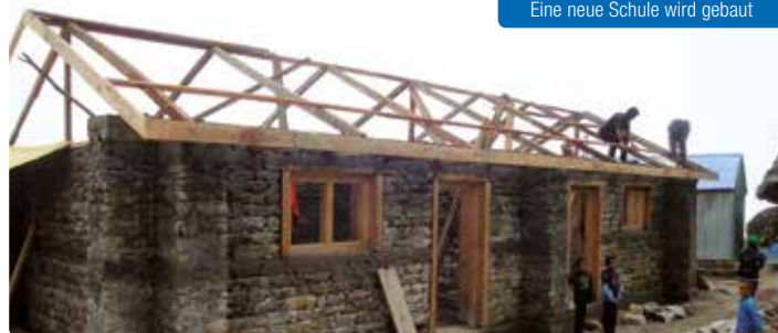
Eine neue Schule wird gebaut
